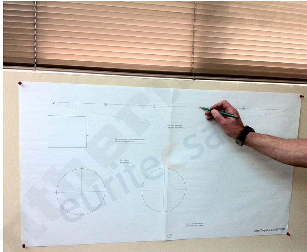
Marcar los agujeros de entrada y salida de aire y del desagüe (solo en bomba de calor)
