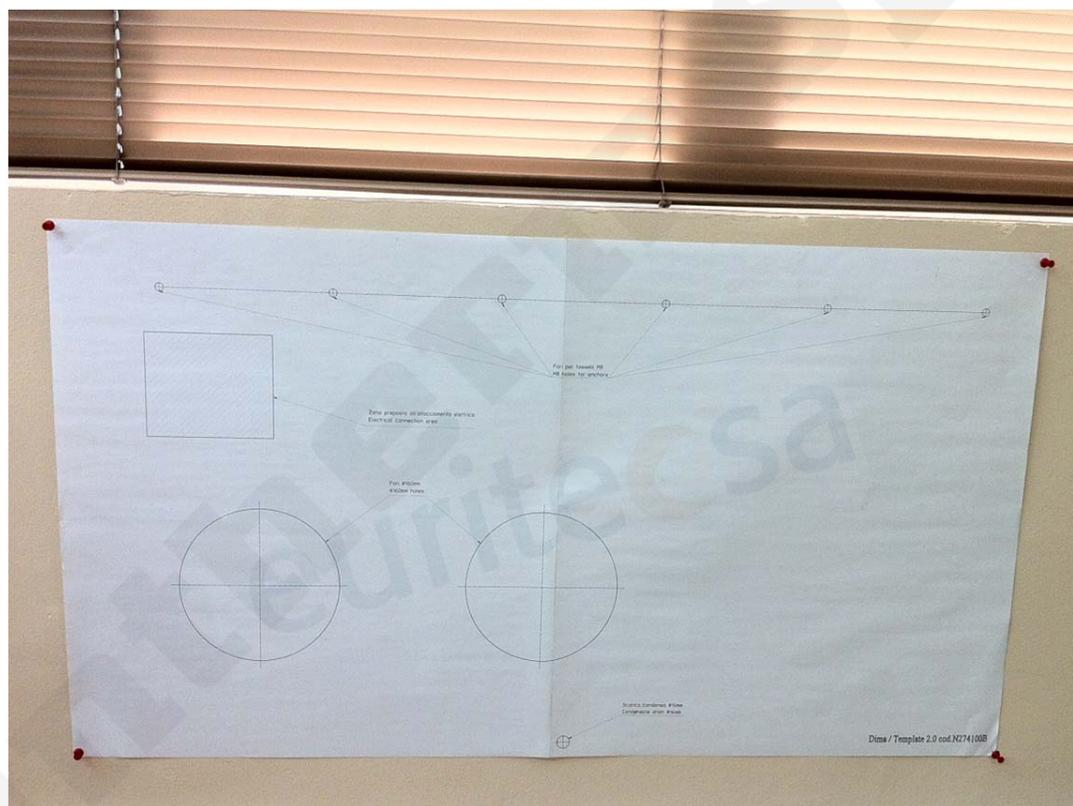
Marcar los puntos del soporte, para sujetar el equipo
